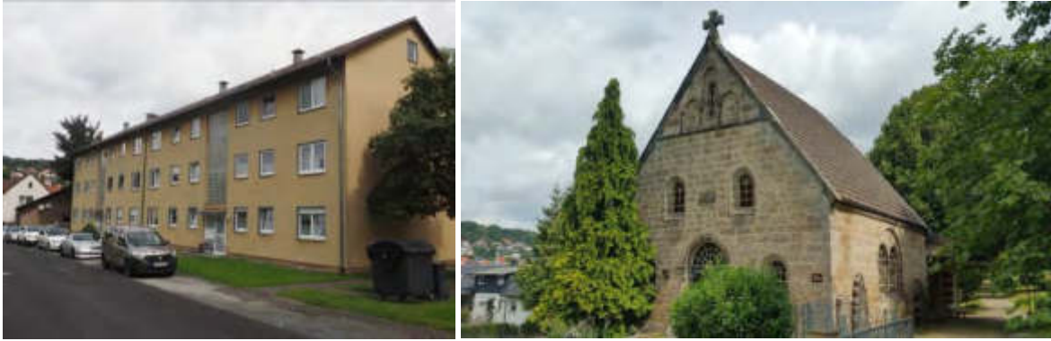
Abbildung 9: Zeilenbau an der Friedhofstraße | Friedhofshalle
