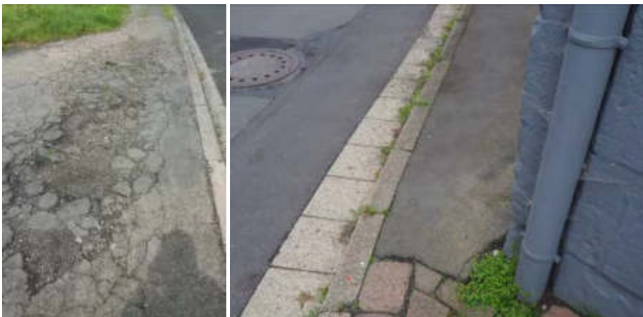
Abbildung 23: Gehwegschäden Friedhofstraße | Engstelle Obere Scheidquelle
