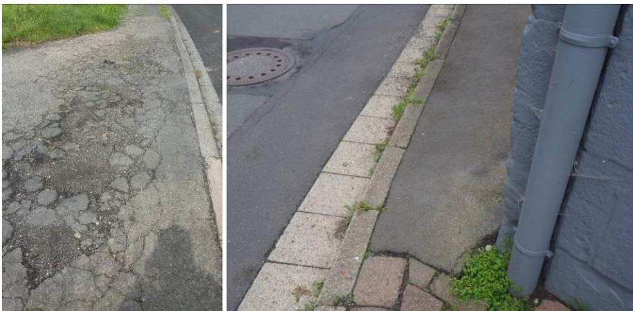
Abbildung 25: Gehwegschäden Friedhofstraße | Engstelle Obere Scheidquelle, eigene Aufnahmen
